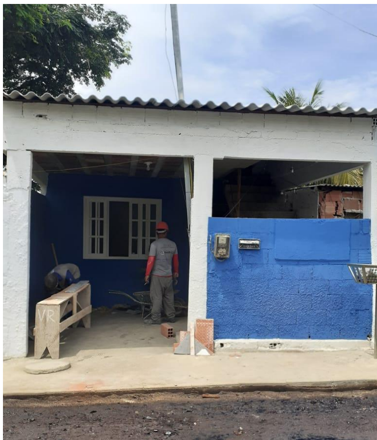
Figura 3: Realização dos serviços de reparo.
